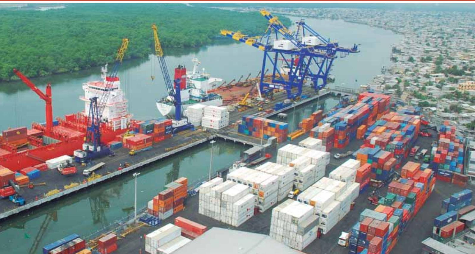
Construidas en el año 2010 en China, poseen una capacidad de levante de 50 toneladas bajo spreader e incluso de hasta 60 toneladas bajo viga de carga. Además, destaca su alcance de pluma de 37 metros y su velocidad de izaje, que puede llegar a 90 metros/minutos con carga y a 180 m/min solo con spreader.
