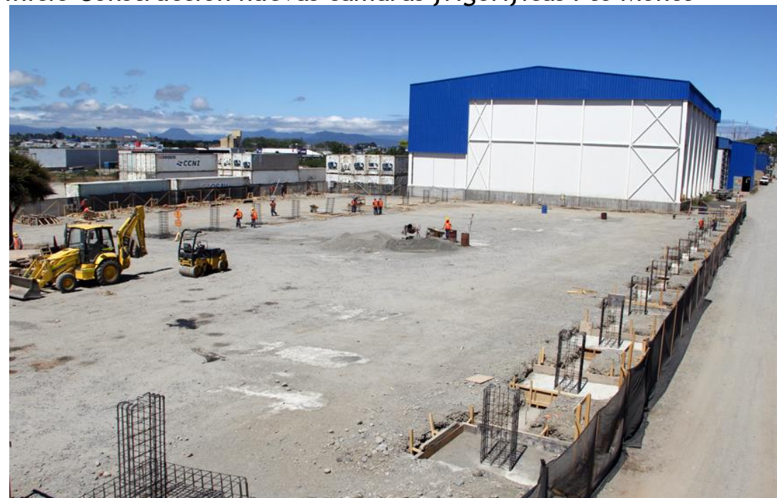
Inicio Construcción nuevas cámaras frigoríficas Pto Montt
