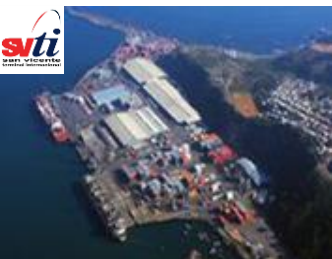
San Vicente Terminal Internacional S.A.
